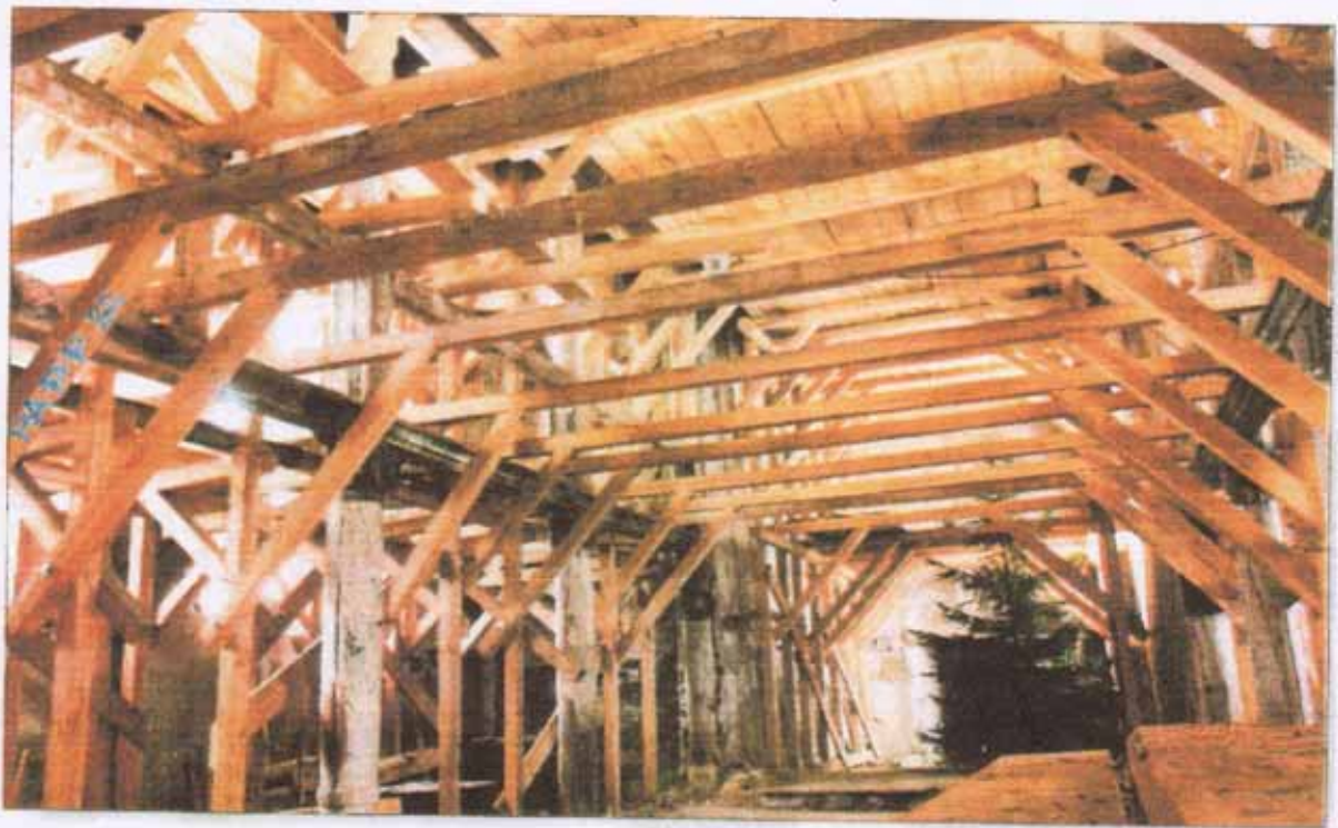
IDEENREICH: Die kunstvolle Holzkonstruktion stützt Dach und Tonnengewölbe und dient den Handwerkern zugleich als Gerüst. TA-Foto: A. BRÜCKE
