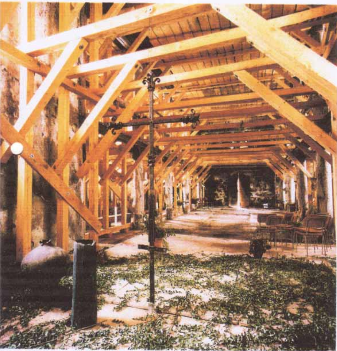
Gerhard Knoblauch vor einem der angegriffenen Sandsteingewände. Unten: Das durchdacht konstruierte Stütz- und Arbeitsgerüst im Kirchenraum
